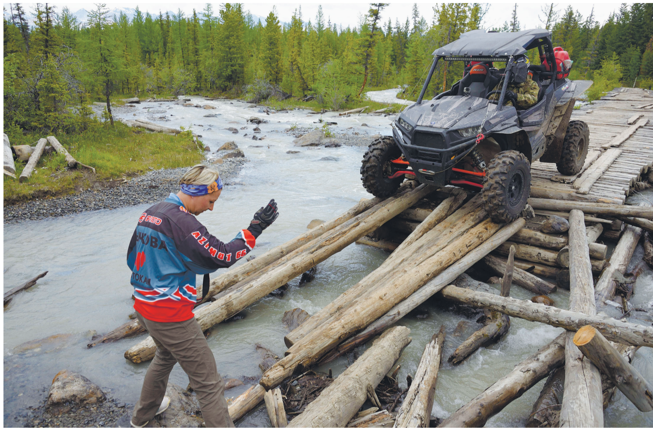
Разрушенный мост для автотуриста не проблема.
